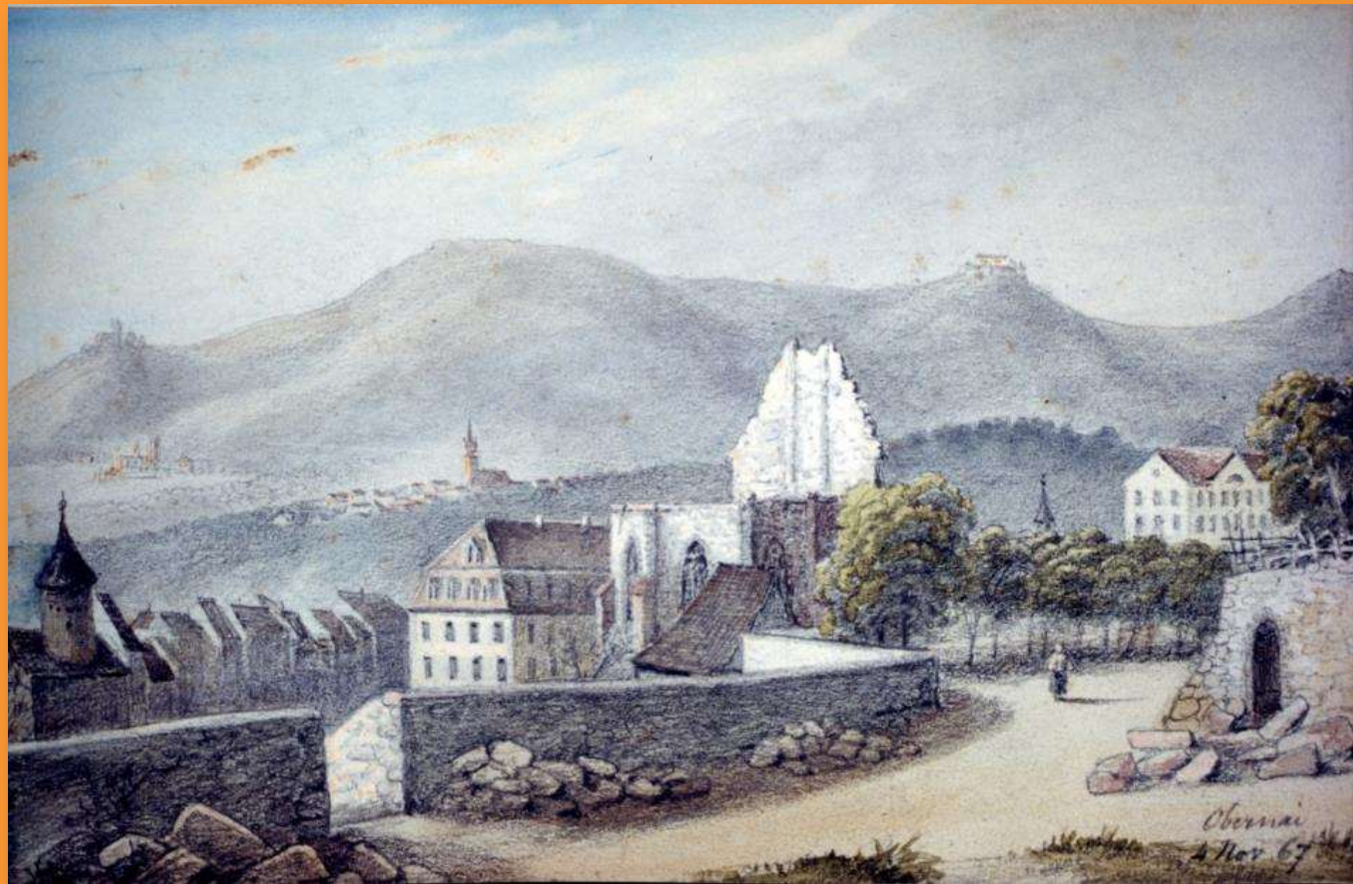
Démolition de l'église à partir de 1867
