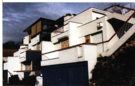
▲ Immeuble situé en surplomb de la rue de la Moyenne Corniche
